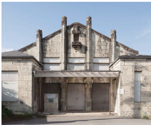
写真1 旧大谷公会堂（1926年竣工）
