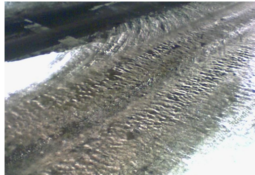
写真-2 積雪凍結路面の凹凸起伏の観測結果 (そろばん道路)
