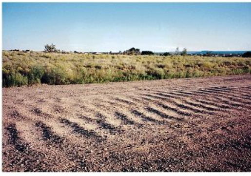
写真-1 凹凸起伏が自然発生した未舗装路の一例
