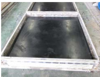
図4 硬質ゴムの設置
