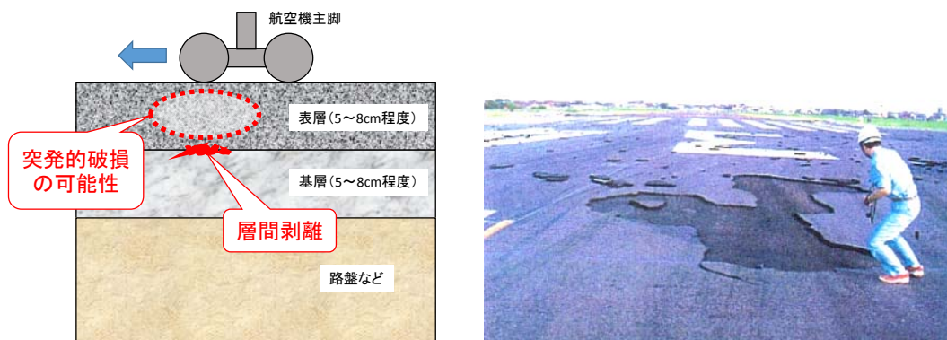
図-1 層間剥離に起因した破損イメージ 写真-1 層間剥離に起因した滑走路の大規模破損
