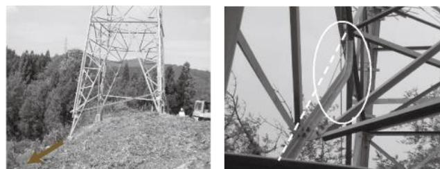
図2 地盤変状に起因する鉄塔の損傷事例
