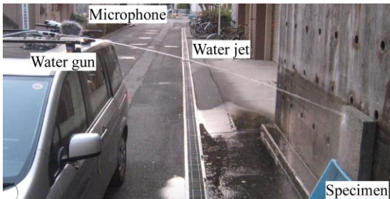
図8 走行しながらの水撃音響法試験
