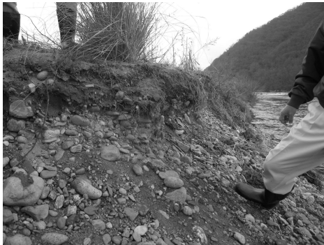
写真1 側岸浸食の状況
