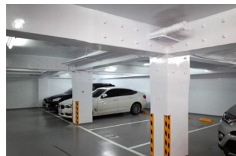
写真 4-1-3. 地下駐車場。構造補強の様子が確認できる
