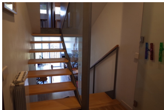
写真 4-1-5. 左上の斜めのスラブに開口部を設けて二戸一化した
