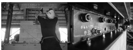
(a)施工状況 (b)摩擦ダンパー
