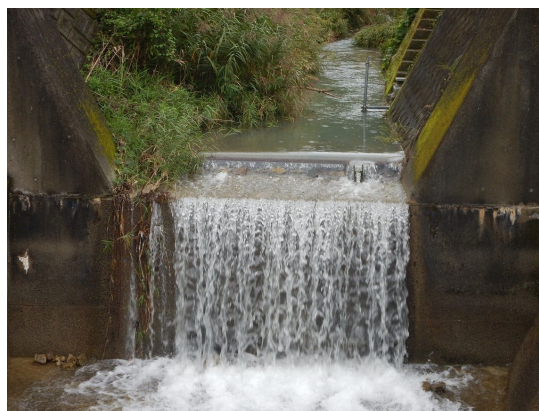
写真1 床固工と水位計
