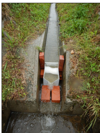
写真2 排水路に設置した堰
