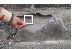
塀（凝灰岩）16500ppm
