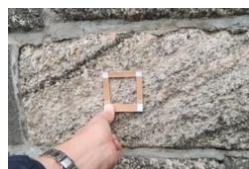
塀（凝灰岩）1920ppm
