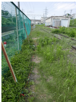
図1 側線の設置状況
