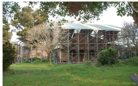
写真3 隆徳殿素屋根
