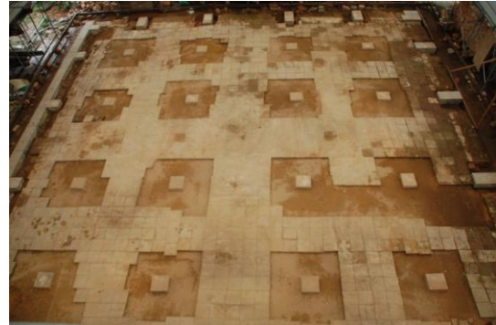
写真6 隆徳殿の基壇修理
