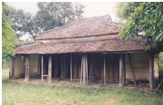
写真1 隆徳殿南面（修理前）
