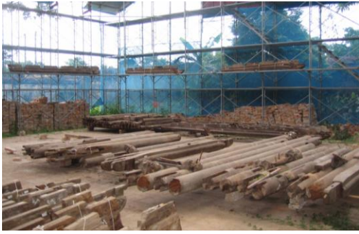
写真4 隆徳殿の解体および部材調査
