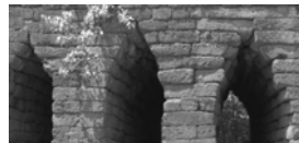
写真3 アーチ部が尖塔形の橋梁
