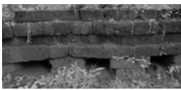
写真2 アーチ部が方形の橋梁
