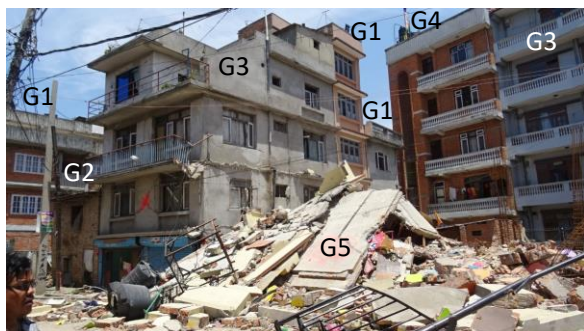
図-3 Khusibu地区の中央部に位置する重篤な建物被害が集中した地域の状況。GはEMS98による被害グレード。
