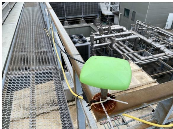
図3 ①の位置に設置した基準局用 GNSS アンテナ
