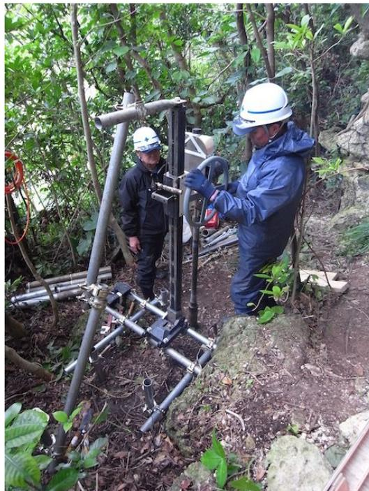
図3 ボーリング掘削の様子
