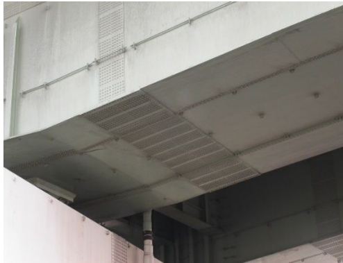
写真 1 鋼箱桁の高力ボルト摩擦接合
