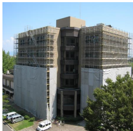
図2 熊本大学構内の地震後の点検 (6階建て、外壁面積約3000m 2 )
