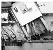
写真2 柱脚の引き抜け
