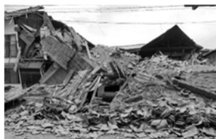
写真1 木造住宅の倒壊
