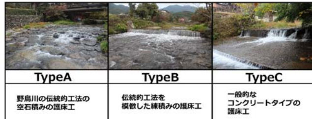
図-1 野鳥川の護床工の分類 (TypeA: 空石積み、TypeB: 練り石積み、TypeC: コンクリート)
