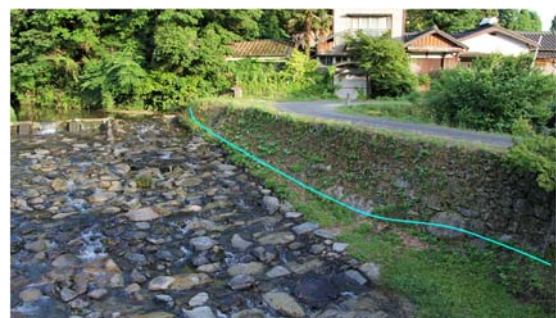
図-9 平水時における状況 (護床工 No. 7) : 写真中青線は出水時の水面形
