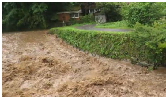
図-8 H29 年 7 月豪雨災害時における出水状況 (護床工 No. 7)
