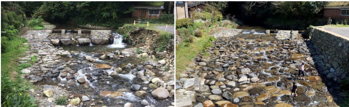
図-12 左) 被災直後の護床工の写真。右) 災害復旧事業により復旧された同護床工の写真。被災前に行っていた本研究の測量、被災直後の詳細な構造調査、治水機能や環境機能の定量的評価の成果が復旧事業に大いに活かされた。
