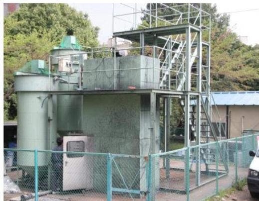
図1 宇都宮市下水処理場に設置した磁化活性汚泥法パイロットプラント。1日50人分の下水を処理する。
