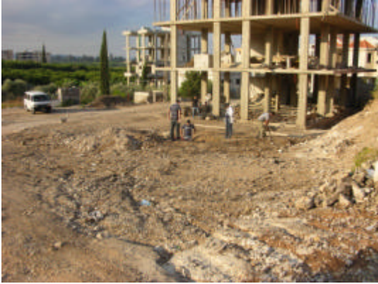
T.01 全景・清掃前(北東から)
