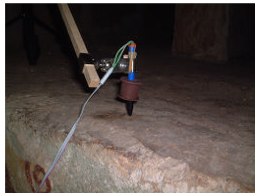
可搬型熱伝導率計による壁面・石材の劣化度測定
