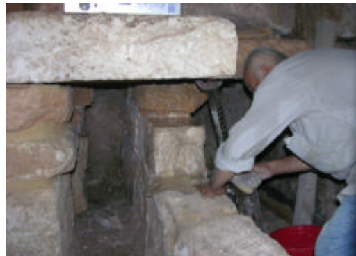
オリジナル石材による納体室の修復( EL2-1、3-1)
