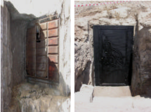
保護扉の交換(左：旧扉 右：新扉)
