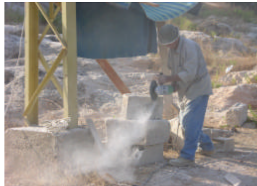
納体室修復に使用する新しい石材の加工
