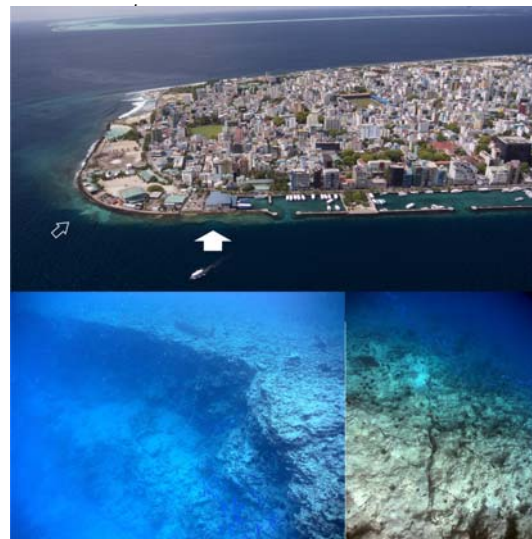
図3 マーレ北東部の崩壊 上: 2002年崩壊地(白矢印)を北(礁湖側)より望む(2008年9月撮影)。下左: 崩壊地、下右: 崩壊地周辺のサンゴ礁でみられる亀裂。礁縁部(手前側、水深3m)から礁湖側斜面深部まで亀裂が連続する。
