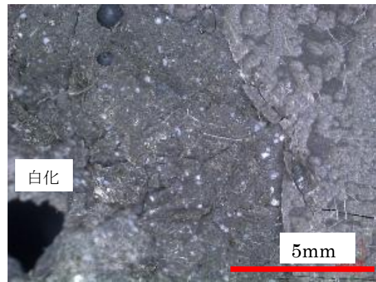
図7 モルタルCのコーンクラック周辺部
