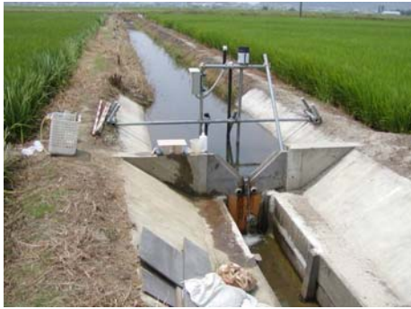
写真1 排水路堰上げ
