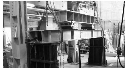
写真-1 載荷試験のセットアップ状況
