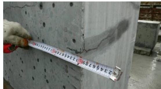
図1 せん断補強筋周囲、主筋周囲、かぶりのひび割れ
