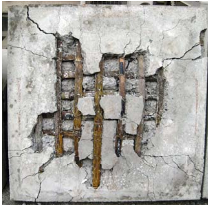
写真-2 床版 A (配筋：密，交点樹脂接合)
