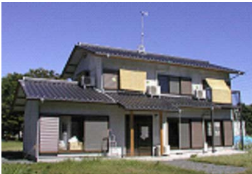
図1 実験用戸建住宅外観
