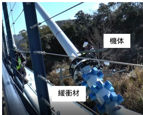
図-4 基部緩衝材と機体の設置状況
