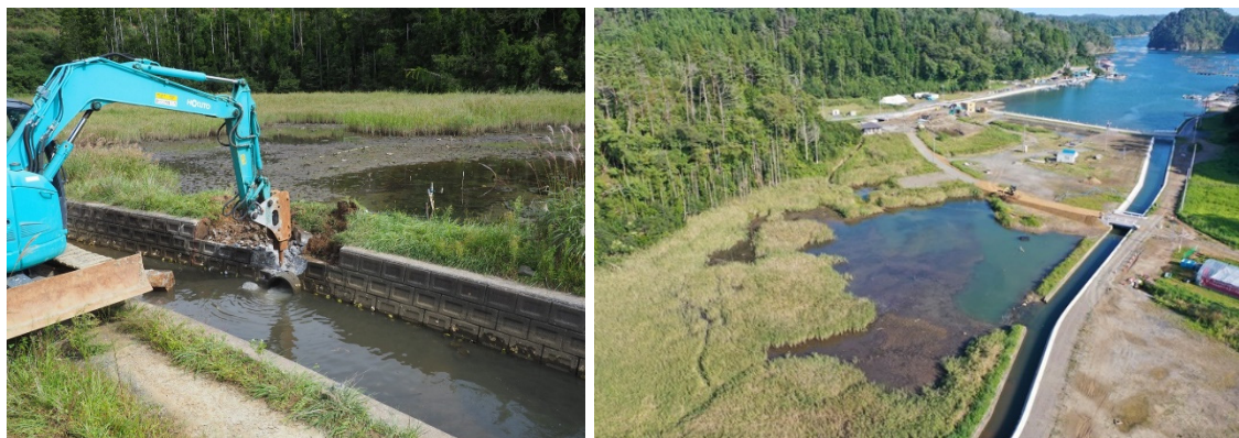
図2 土管部分の開削(左)、本研究を通じて保全された塩性湿地の全景
