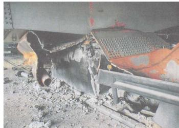
図-1.1 倒壊した鋼製橋脚
