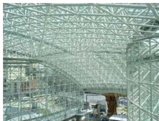
図 1. 屋根・壁一体型構造の面外方向の崩壊機構制御によるガラスパネルの落下防止機構の確立
