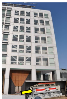
写真 3 新設された積層ゴム
