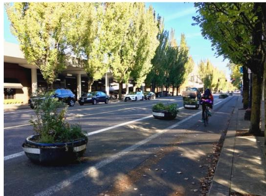
図2 プランターによる自転車レーンの確保
