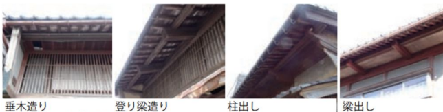
図3 各軒先構法写真
