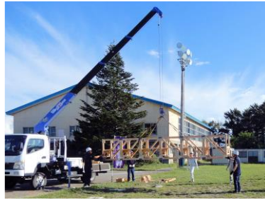
(b) 架設ヤードから河川上へ 写真 5 架設状況
