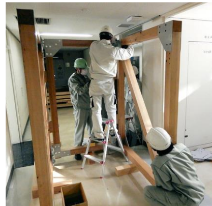
写真6 手作業による組立て
