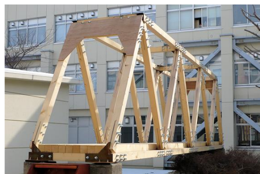
写真1 函館高専 木製トラス橋
