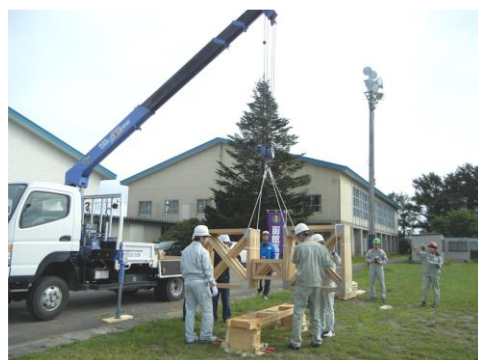
写真4 架設台への設置
