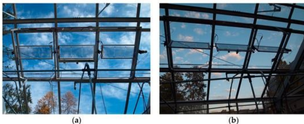
図 2 本研究で開発した半透過型太陽電池ブラインドシステム
