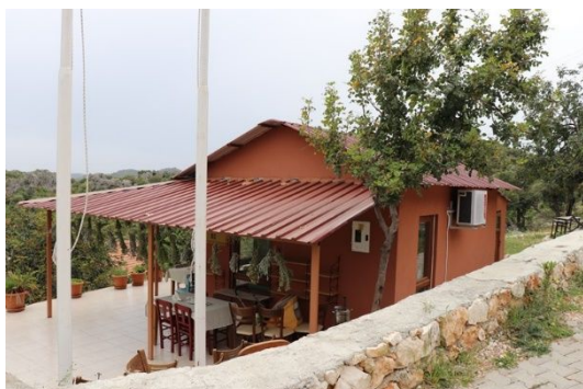
図表 5 カパクル村につくられた休憩所
