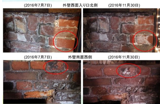
図 2 塩類析出状況の変化記録の一例
