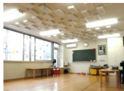
図 2 吸音材設置風景 (条件 D)
