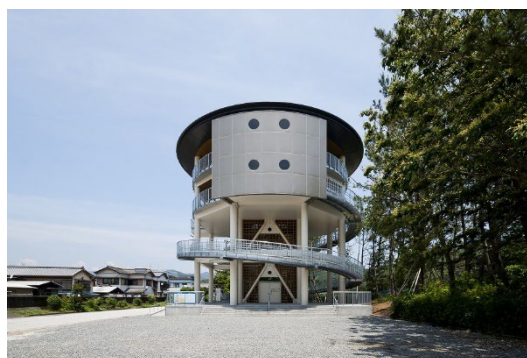
図1 第1号津波避難タワー
