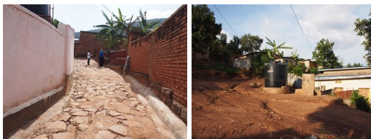
Figure 4 住民によって整備された道路舗装（左）と共同給水栓（右）
