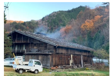
写真2 木曾の板葺屋根(サワラ)
