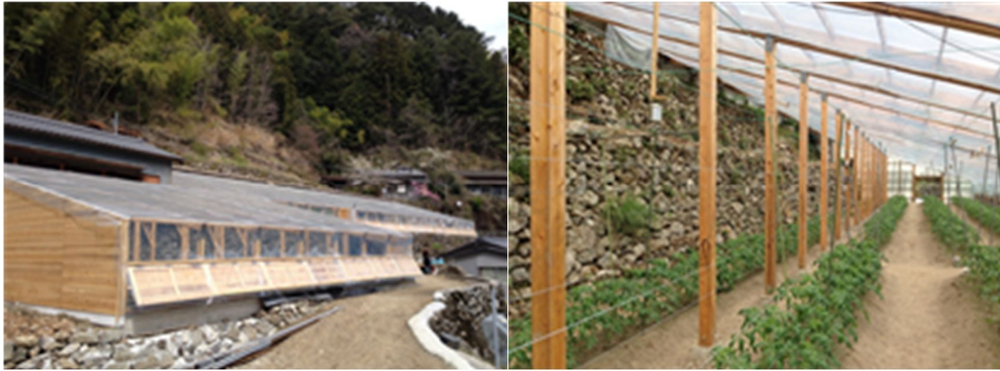
図1 石垣蓄熱ハウスの外観と内部状況
