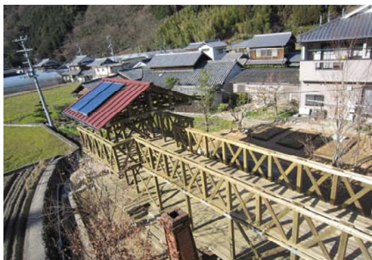
図2 完成した翠ゾーン
