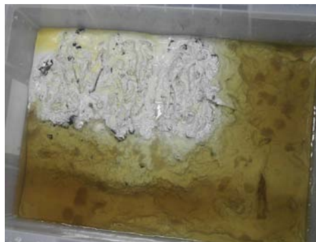
写真5 普通コンクリートの劣化状況
