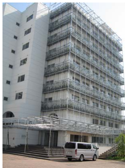
写真-1 建築学棟全景
