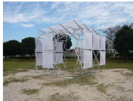
写真 1 展開システムを利用した箱型シェルター
