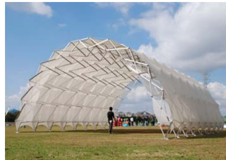
写真 2 半球型の単層ドーム形状のシェルター
