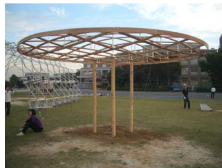
写真 3 木材の初期曲げを利用した プリベンディング・シェルター
